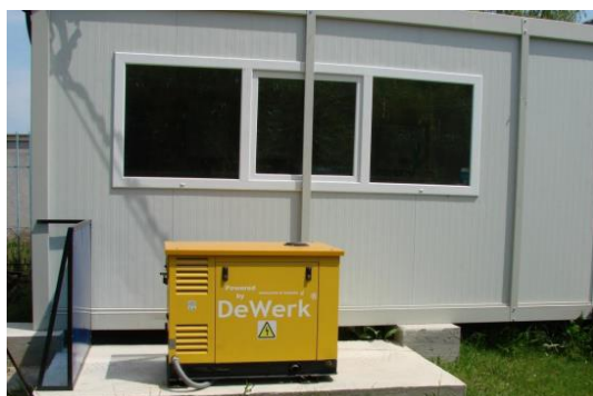
Fig. 9. Diesel DeWerk generator, [2]
